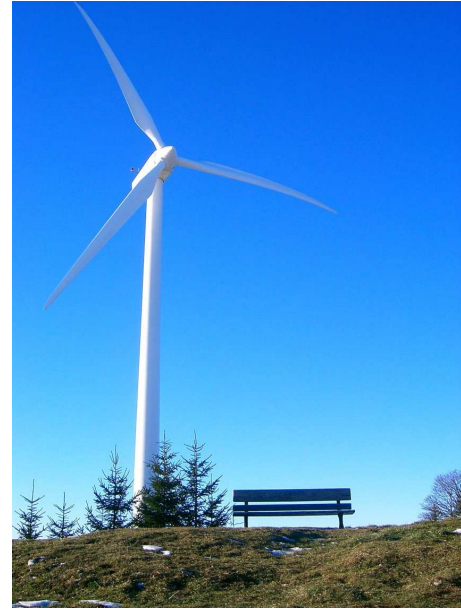
FIG. 4.6 – Éolienne L'énergie paisible
