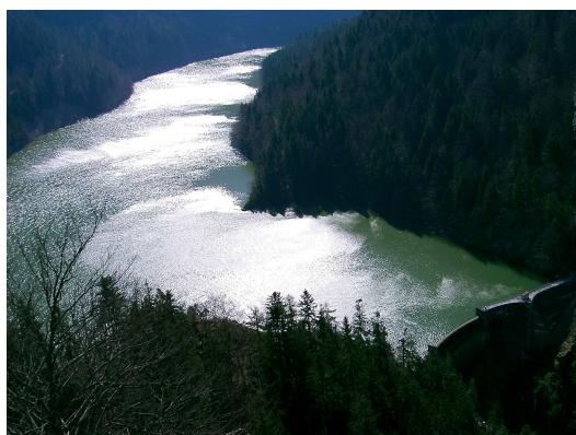
FIG. K.1 – Le barrage du Châtelot Sur le Doubs dans le jura.
