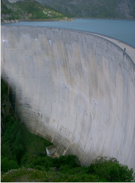
FIG. 4.3 – Barrage d'Emosson D'une hauteur de 180 m et largeur de 560 m 39
