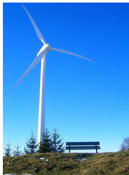
Figure 7.6 – Éolienne L'énergie paisible
