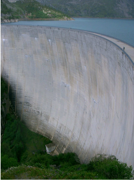
Figure 7.3 – Barrage d'Emosson (Suisse) D'une hauteur de 180 m et largeur de 560 m 42
