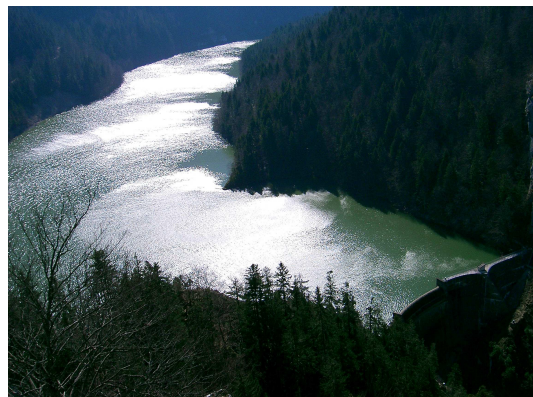
FIGURE K.1 – Le barrage du Châtelot Sur le Doubs dans le Jura.
