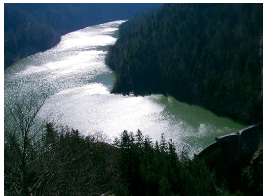
Figure K.1 – Le barrage du Châtelot Sur le Doubs dans le Jura.
