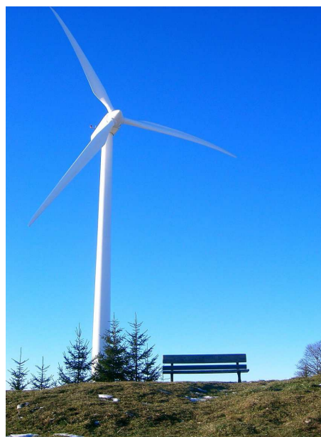
Figure 7.6 – Éolienne L'énergie paisible
