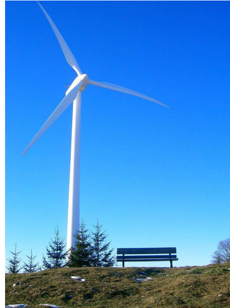
FIGURE 7.6 – Éolienne L'énergie paisible
