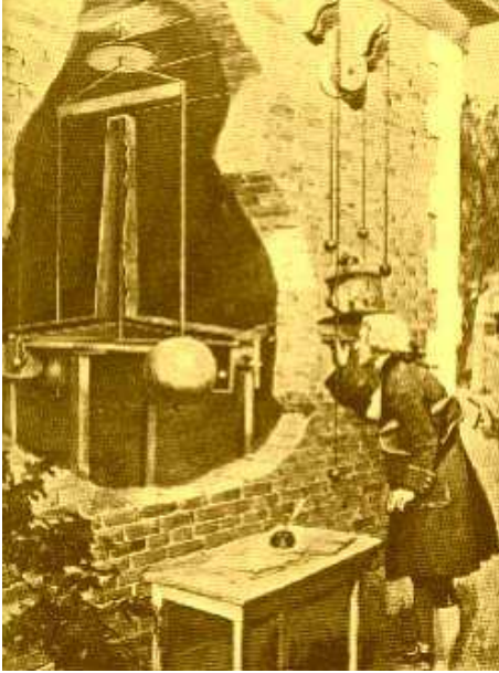
FIGURE 3.1 – La balance de Cavendish Mesurer la force de gravitation 36
