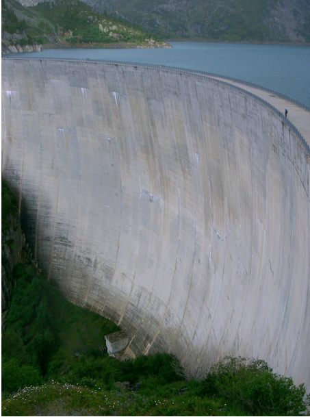
FIGURE 4.3 – Barrage d'Emosson (Suisse) D'une hauteur de 180 m et largeur de 560 m 41
