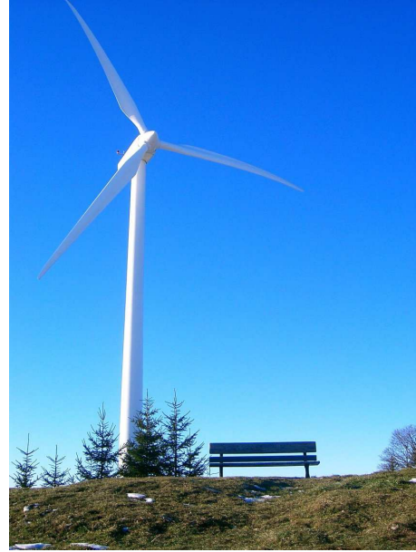
FIGURE 4.6 – Éolienne L'énergie paisible
