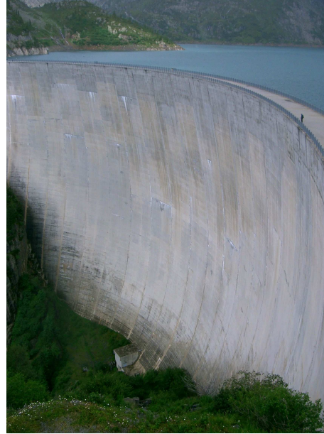
FIG. 4.3 – Barrage d'Emosson (CH) D'une hauteur de 180 m et largeur de 560 m 38
