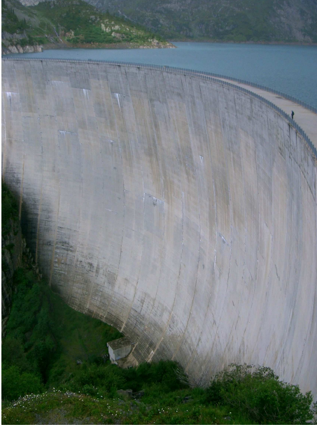
FIGURE 4.3 – Barrage d'Emosson (Suisse) D'une hauteur de 180 m et largeur de 560 m 68
