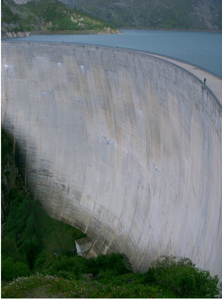
Figure 7.3 – Barrage d'Emosson (Suisse) D'une hauteur de 180 m et largeur de 560 m 68
