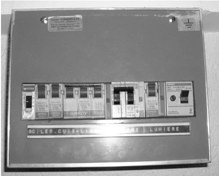
FIGURE 3.6 – Disjoncteurs
